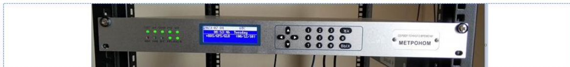
Рис.4 Крепление СТВ Метроном-810 в стойку 19"
